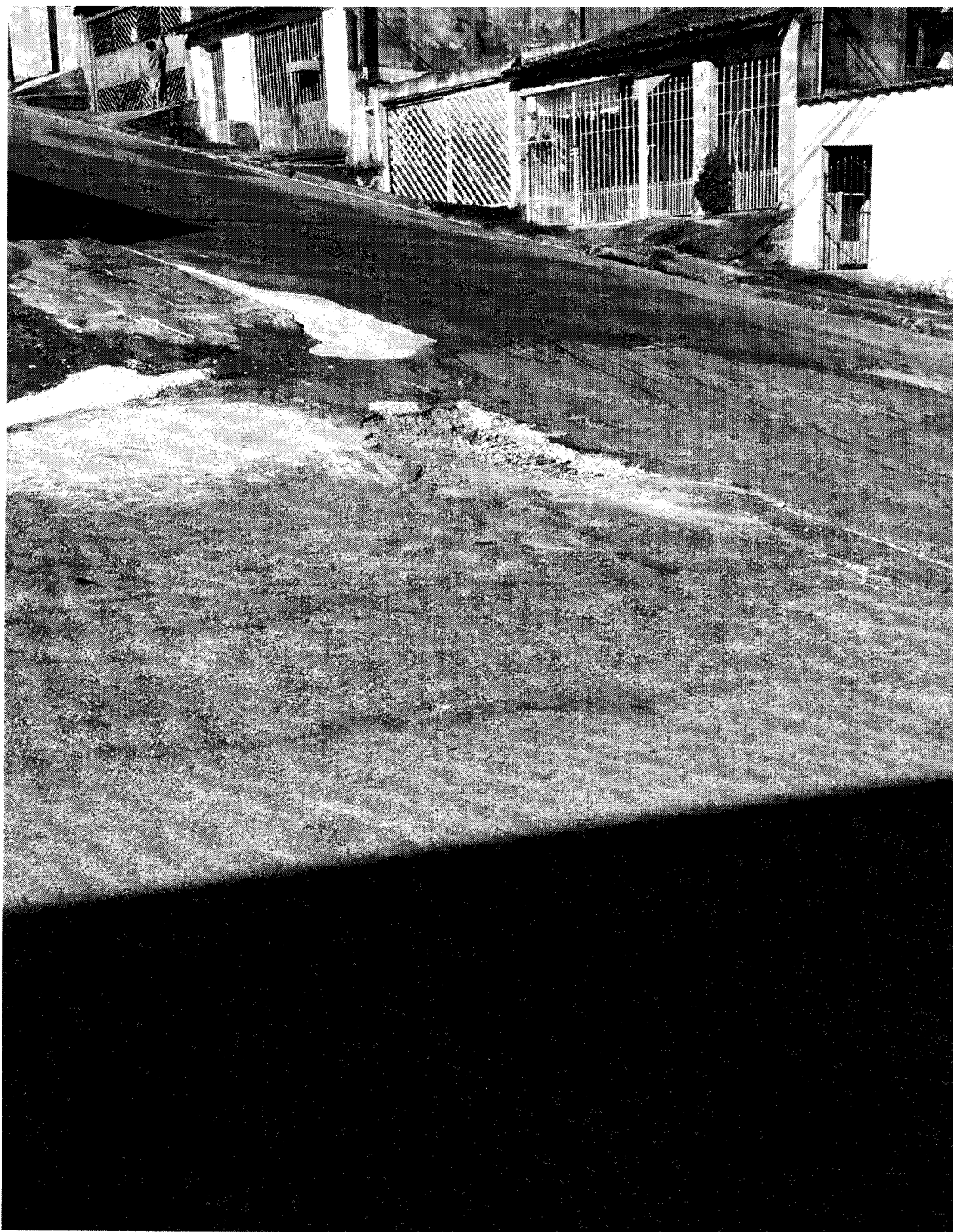
MANUTENÇÃO ASFÁLTICA NA RUA JULIO ARAGAO COM A CORONEL LEGEUNE. VILA CECILIA
